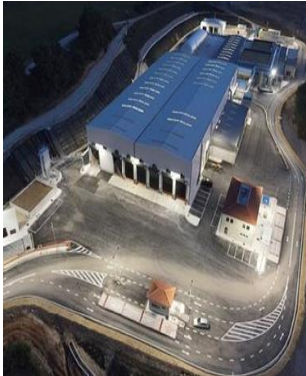
Μονάδα Επεξεργασίας Απορριμάτων Ηλείας
